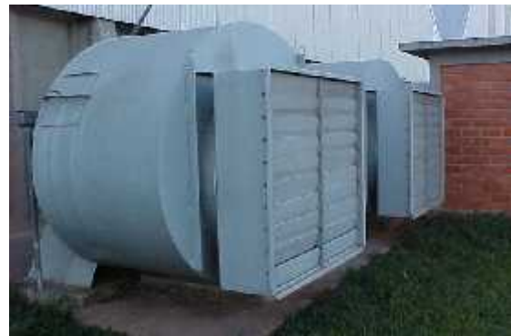
Figura 7 - Ventilador ou exaustor
